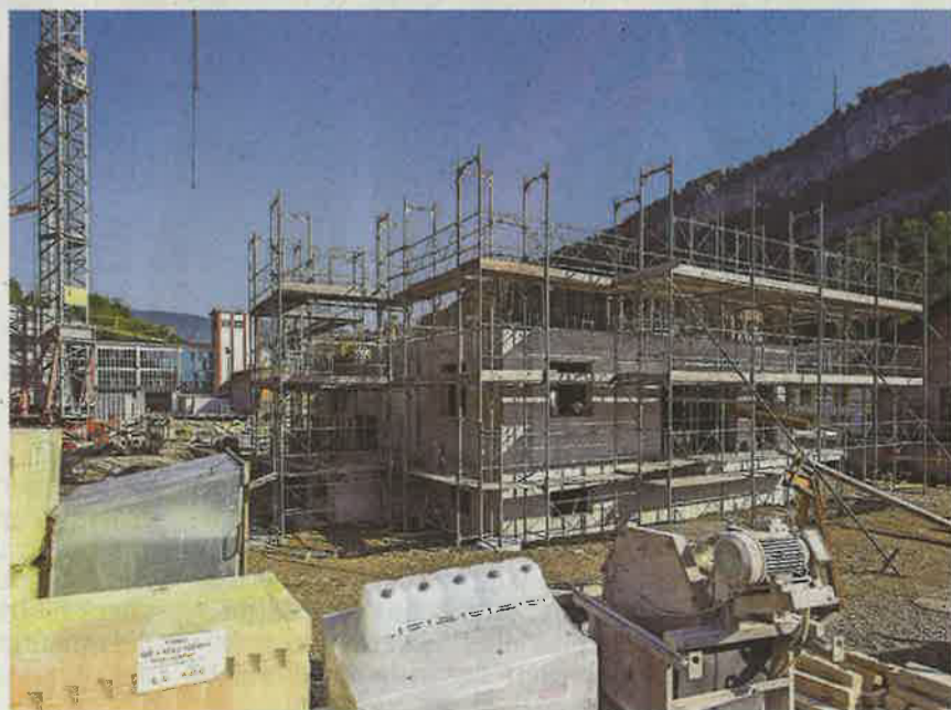
Ende 2018 wird das noch im Bau befindliche neue Brandhaus fertiggestellt sein.
