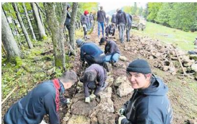
Es wird fleissig an der Trockenmauer gebaut.
